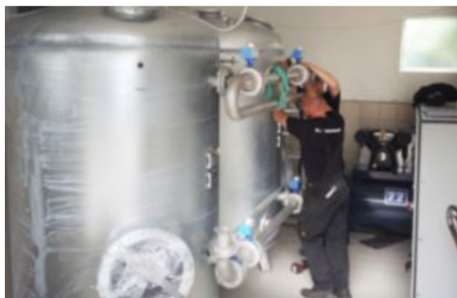
■ Håndværkere i gang med at opsætte værkets nye beholdere. Foto: Privat
